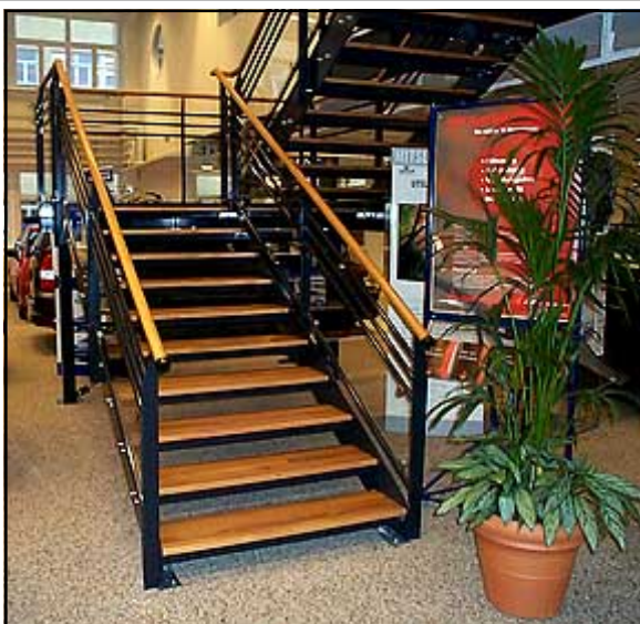
Mitsubishi, Hammarby. Ståltrappa i två löp med räcken av glas och följare av stål. Steg och handledare av massivt trä, tillhörande valvräcke, pulverlackerad
