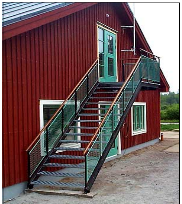
Sundbergs smide, Gävle. Ståltrappa med steg av gallerdurk, stålräcken med nät och handledare av massivt trä. Varmförzinkad och pulverlackerad.
