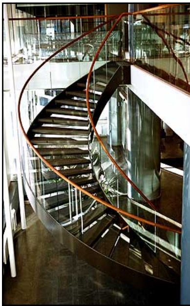
Metrolit, KPMG, Jakobsgratan Stockholm. Helsvetsad svängd ståltrappa med helglasat ingjutet glasräcke. Steg av natursten med stålupplag, handledare av massivt trä.
