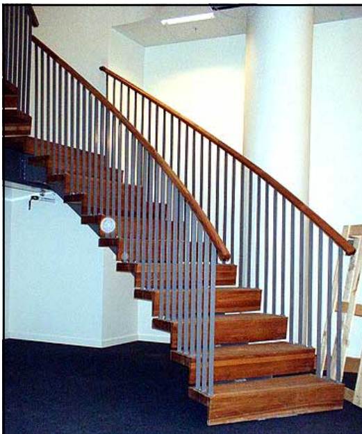
Q-Gruppen, Handelsbanken, Hötorget i Stockholm. Svängd ståltrappa i tre löp med en mittvang byggd i lådkonstruktion under stegen. Barnsäkert stålräcke. Handledare, steg och sättsteg av grovt massivt trä.
