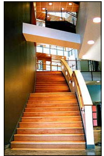
SKANSKA, ITT-Flygt, Sundby Park. Svängd ståltrappa i två löp med vilplan. Stålkonstruktion i räckesballustrad och utanpåliggande handledare. Steg, sättsteg och handledare i massivt trä.
