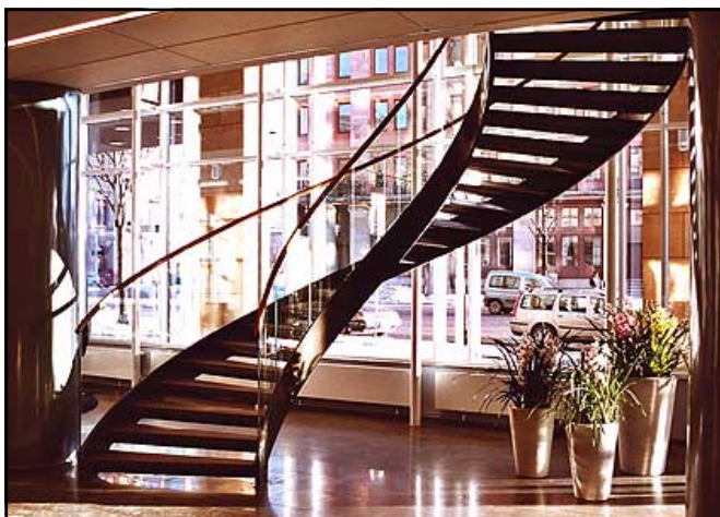
Metrolit, KPMG, Jakobsgratan Stockholm. Helsvetsad svängd ståltrappa med helglasat ingjutet glasräcke. Steg av natursten med stålupplag, handledare av massivt trä.
