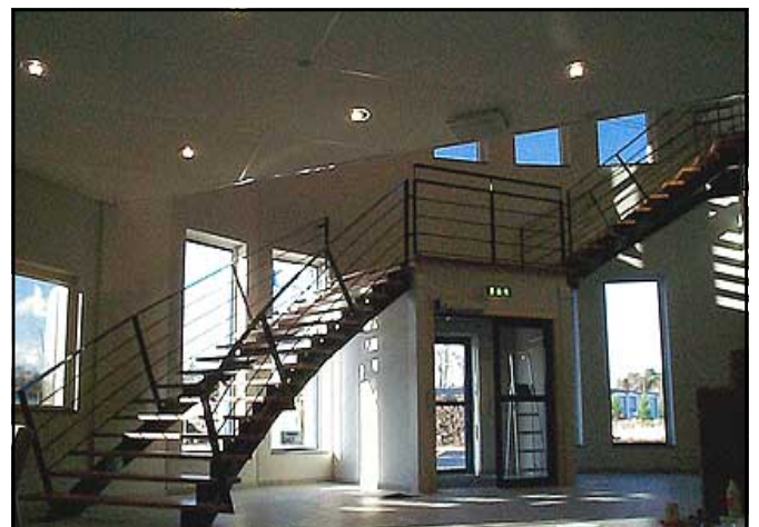
PEAB, Kinnarp. Svängd ståltrappa i två löp med vilplan, dubbla underliggande mittvangstycken. Räcke med stålföljare tillverkat i fartygsstil. Steg av massivt trä.
