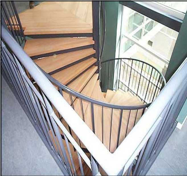
ASTRA, Södertälje. Steg av massivt trä, trappräcke med barnsäkert stålgalleri, handledare av stålrör samt anslutande valvräcken, pulver- lackerad.
