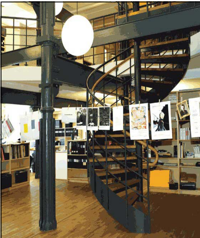
Kv. Lappskon, Münchenbryggeriet, Stockholm. Trappa tillverkad i gammal stil i miljö med gammalt smide. Yttervangar med steg i massivt trä, räcke med följare av stålrör och handledare med lindat läder, pulverlackerad.
